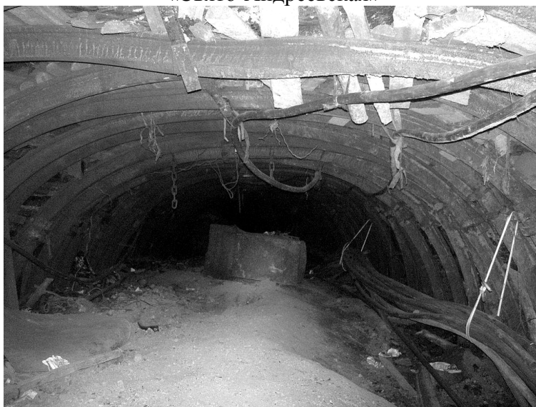
Рис. 4. Выдавливание пород почвы в условиях шахты «Белозерская»
