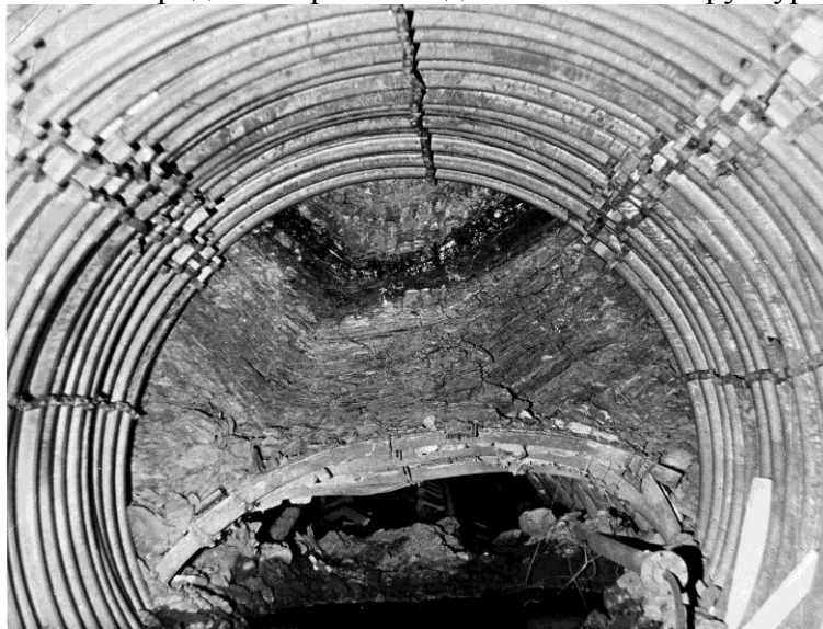
Рис. 2. Образование клина выдавливания пород кровли в условиях шахты «Западно-Донбасская»
