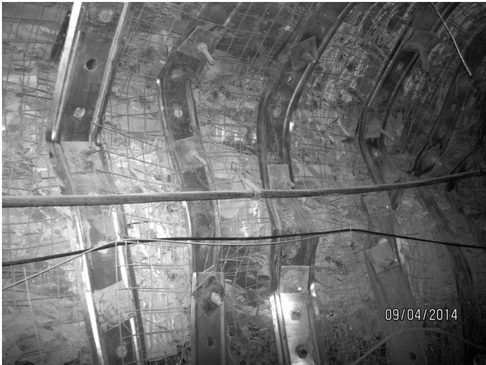
Рис.3. Деформации массива и элементов крепи на ПК 204 при подходе лавы на расстояние 90м. Металлические подхваты складываются «гармошкой»
