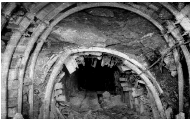
Рис. 9.7. Общий вид 553 бортового штрека позади 553 лавы на расстоянии до 200 м, закреплен рамной крепью АП-3, участок перекрепления у места «завала»
