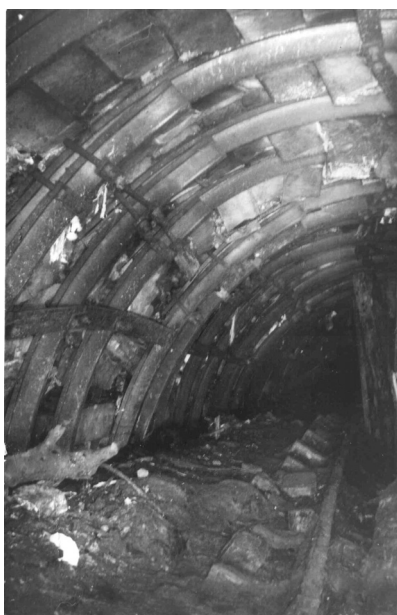
Рис. 9.9. Общий вид 553 бортового штрека в 30-50 м позади 551 лавы, закреплен рамно-анкерной крепью, анкера с гибкими стяжками перекрыты «вспученными» породами почвы
