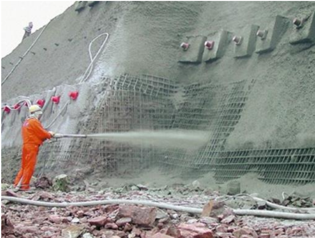
Рис. 1.14. Нанесение бетонной смеси при торкретировании
