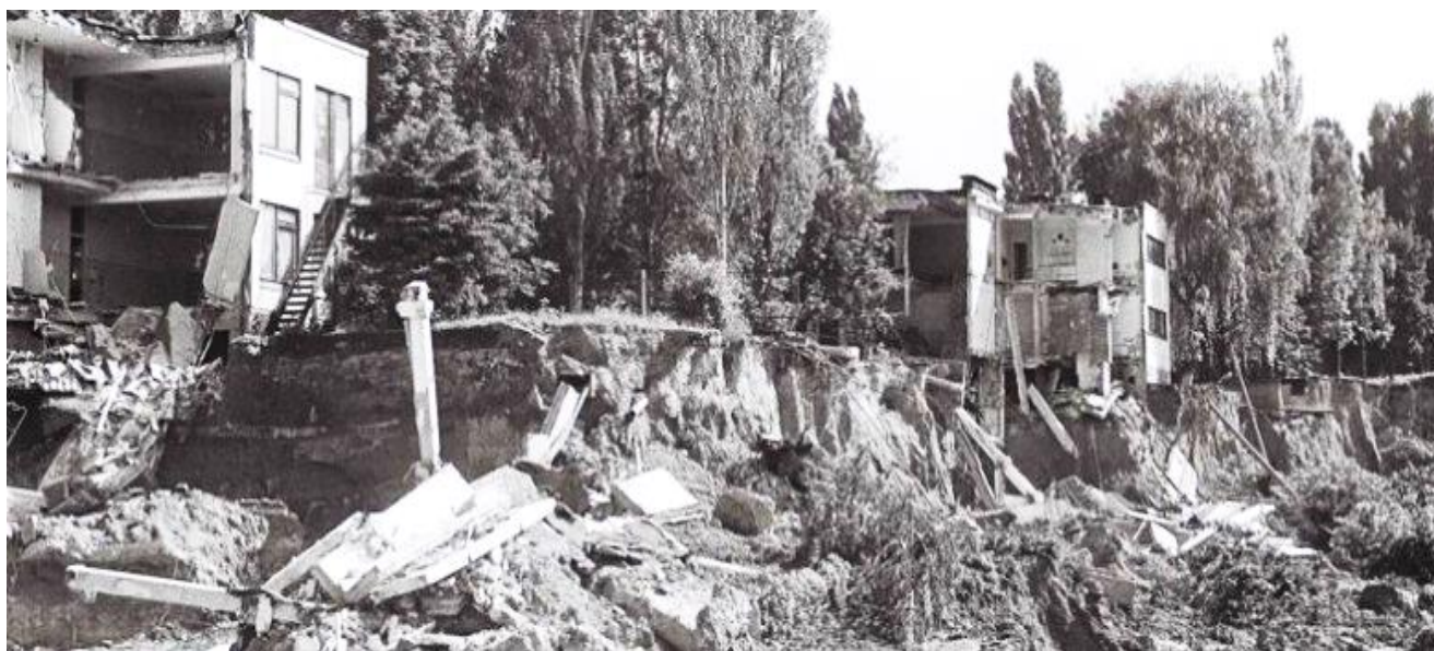
Рис. 1.1. Разрушение здания на ж/м Тополь-1 вследствие оползня
