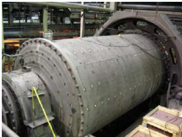
Рис. 3. Внешняя поверхность мельницы с заглушенными болтовыми отверстиями
