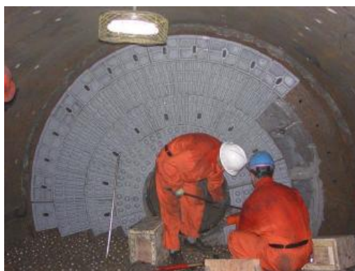
Рис. 4. Установка ММЛ на загрузочном конце мельницы
