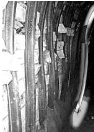
Рис. 2. Порівняння деформацій стояків кріплення в умовах шахти та в результаті розрахунку
