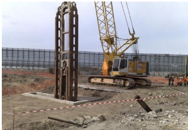
Рис. 1. Розробка виїмки під барету
