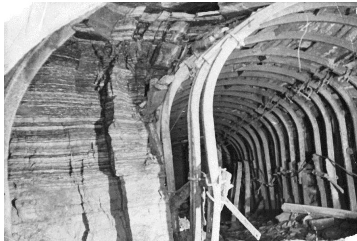
Мал. 2.4. Деформування приконтурних шарів порід. Заїзд в гараж-зарядну на гір. 160 м ш. «Благодатна» [5]
