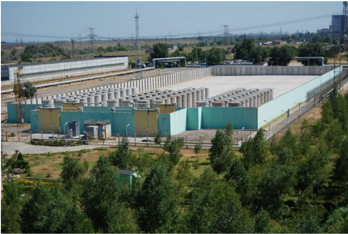
Рис. 4.10. Комплекс сухого сховища відпрацьованого ядерного палива на Запорізькій АЕС
