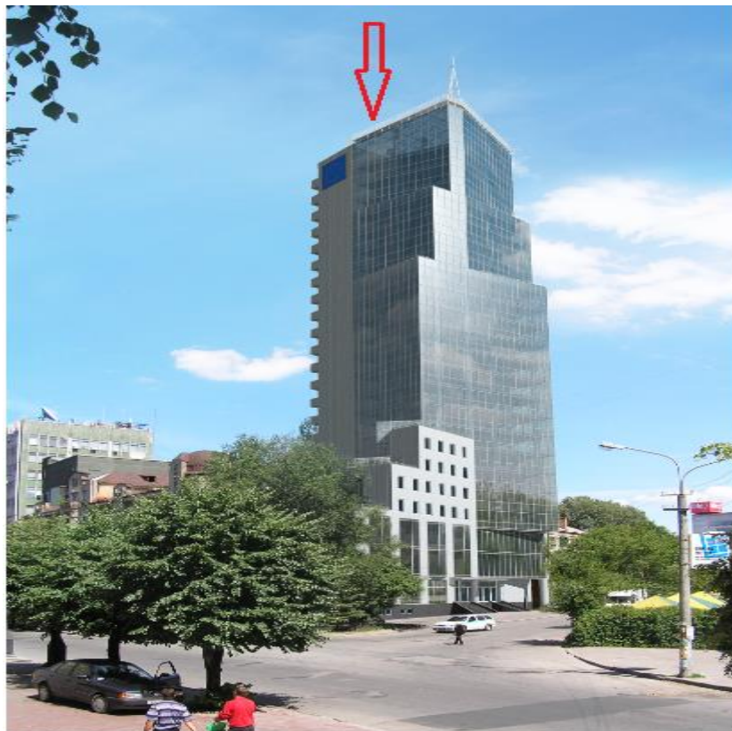
Рисунок 1.4 - Вигляд об'єкту будівництва з рогу вулиць Вознесенської та Челюскіна
