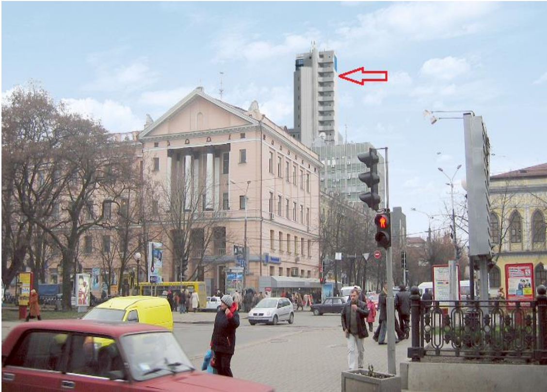
Рисунок 1.2 - Вигляд об'єкту будівництва з рогу пр. Дмитра Яворницького та вул. Вознесенської
