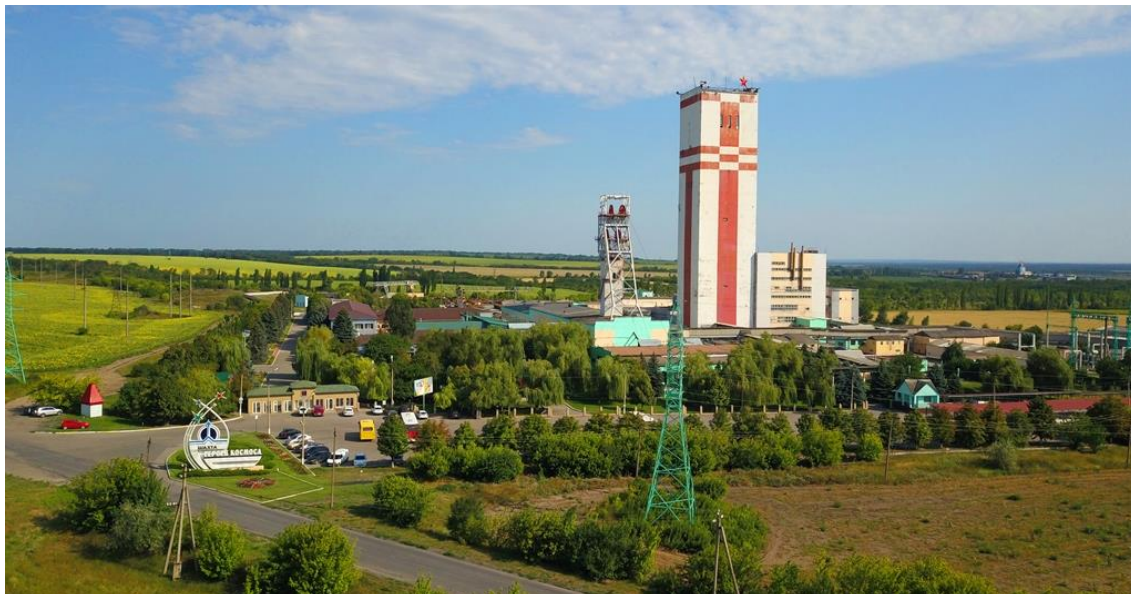
Рисунок 1.2 – Загальний вигляд проммайданчику шахти
