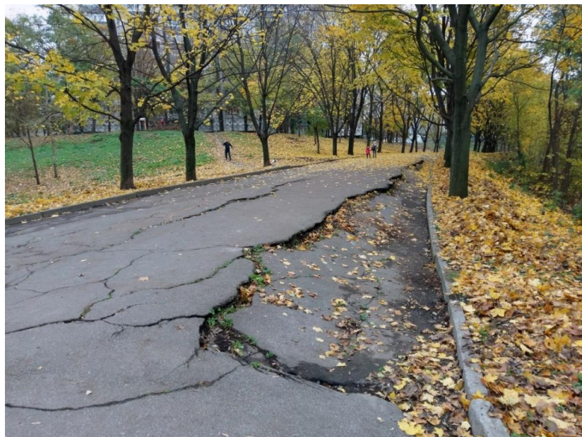
Рис. 1.1 На задньому плані – 16-ти поверховий житловий будинок за адресою проспект Поля, 102д. В безпосередній близькості – руйнування асфальтного покриття по лінії відриву в результаті повільного зсувного процесу (листопад, 2017 р.)
