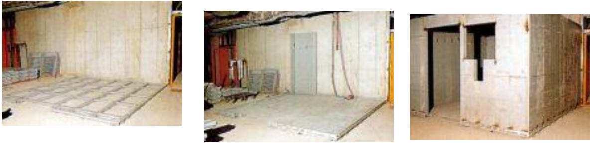
Рисунок 1.1 – Начальні етапи будівництва спеціалізованого банківського приміщення
