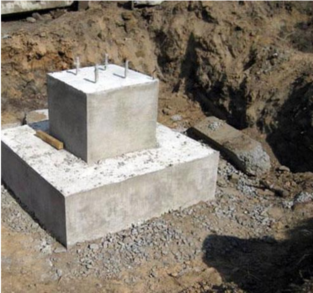
Рисунок 1.5 – Схема стаканного фундаменту
