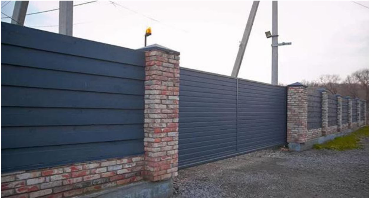
Рисунок 1.2 – Пропускний пункт котеджного містечка
