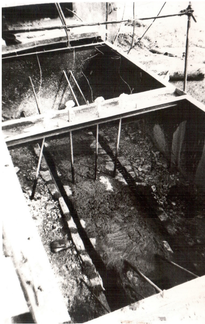
Формування вугільного пласта в ящику і установлення термомпар (1979 р.)
