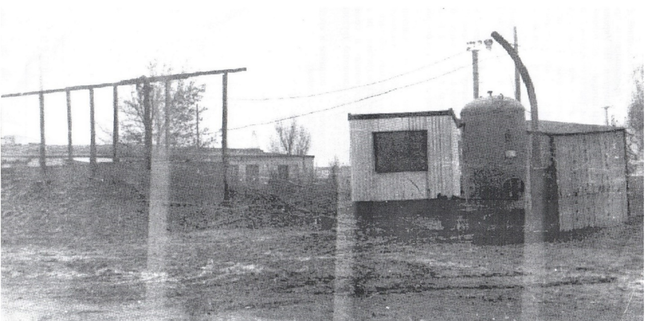
Стендова експериментальна установка на шахті «Тернівська» ВО «Павлоградвугілля». На передньому плані металічний ящик, будка для проживання і ресивер (накопичувач повітря) (1994 р.)
