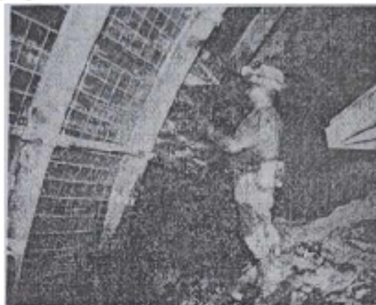
Рис. 1.12 Встановлення міжрамного огородження на шахті «Монополь»
