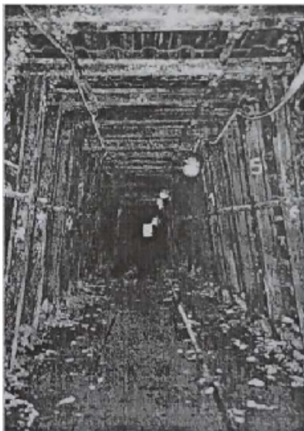
Рис. 1.1 Трапецієподібне рамне кріплення з використанням як міжрамне огородження профільованого листа
