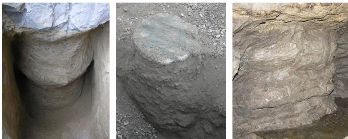
Рис. 4. Ґрунтоцементні колони, виконані на території України: а) в супісках; б) техногенні ґрунти – шлаки доменного виробництва; в) заторфований суглинок
