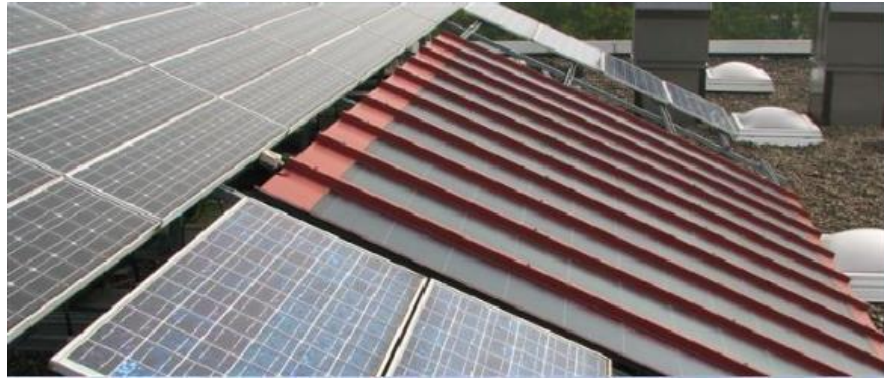
Рисунок 2.7 – Комбінована сонячна станція з теплообмінником
