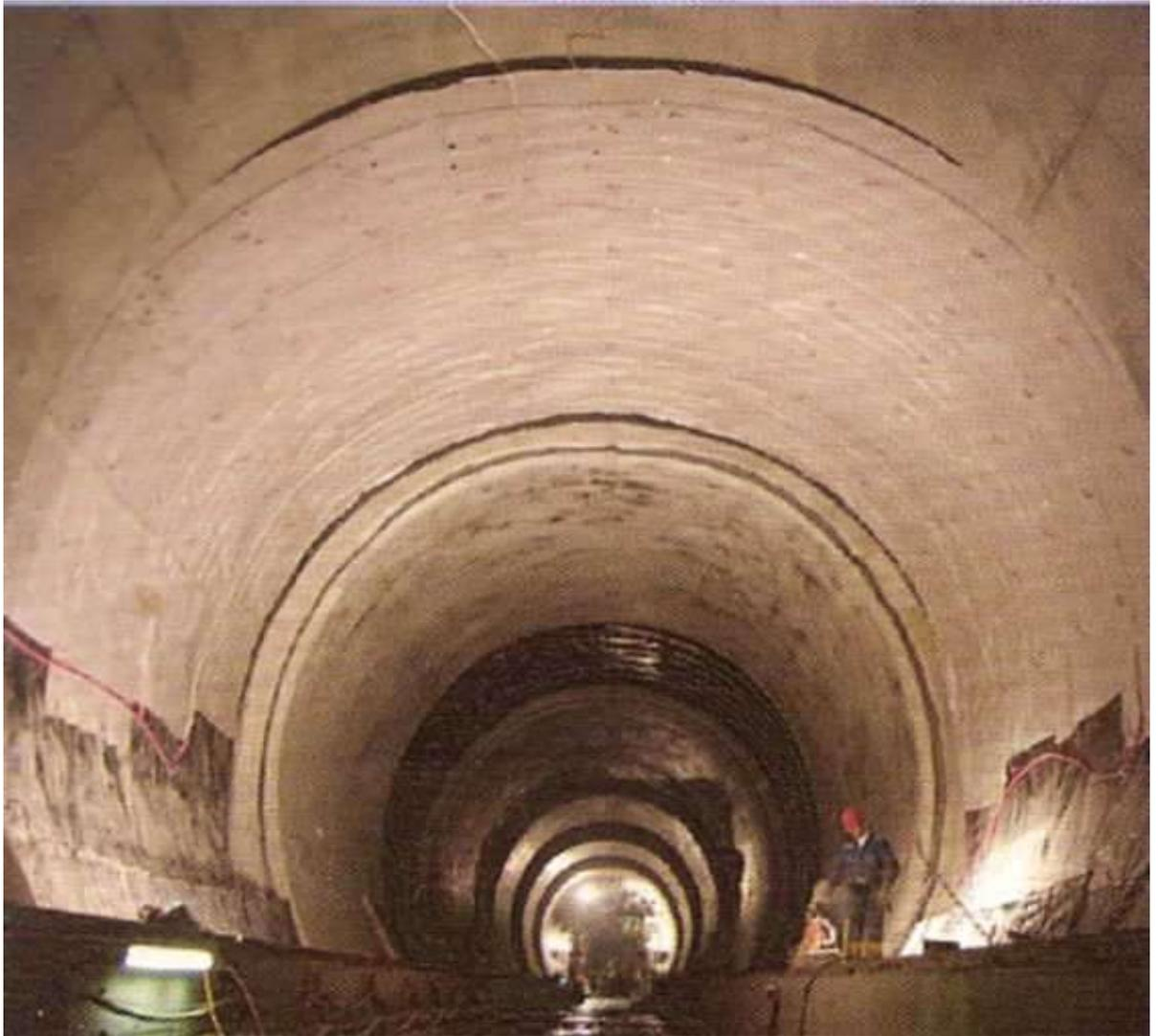
Рис. 15. Монтаж коллектора теплового насоса на опытном участке в туннеле Ляйнцер (Австрия).
