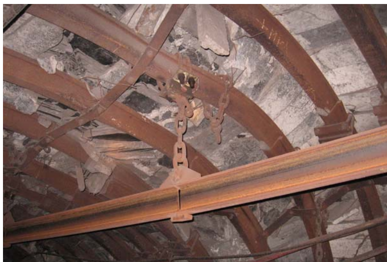
Рис. 3.3. Результат взаимодействия несущей рамы арочной крепи с массивом горных пород после многократного прохождения подвижного состава через стыковое соединение монорельса
