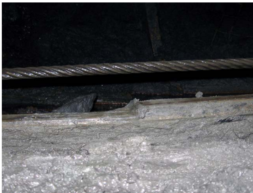
Рис. 3.7. Фрагмент стыкового соединения рельсового пути в 304 бортовом штреке пласта С 6 гор. 260 м шахты «Павлоградская» ПАО «ДТЕК Павлоградуголь»
