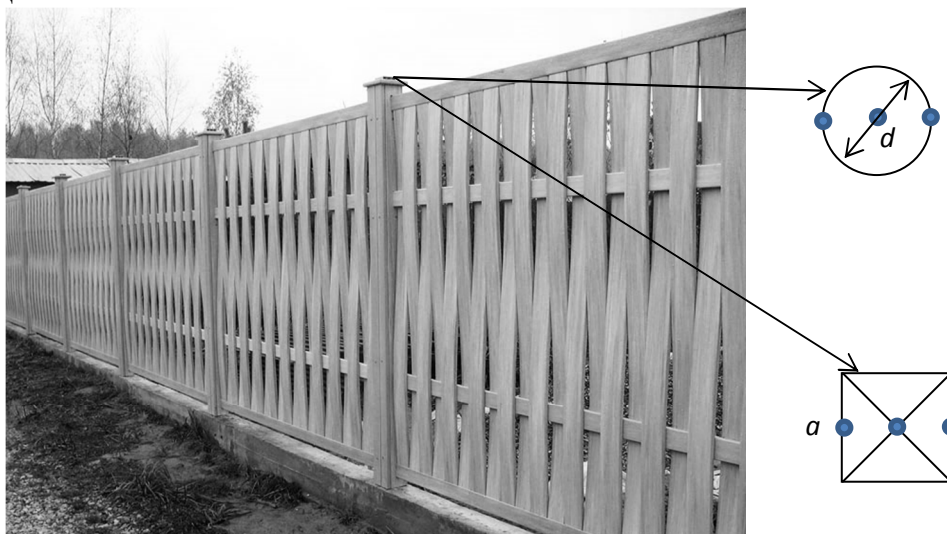
Рис. 2.2. Загальний вигляд дерев'яного паркану та проекції точок кутів поворотів на горизонтальну площину
