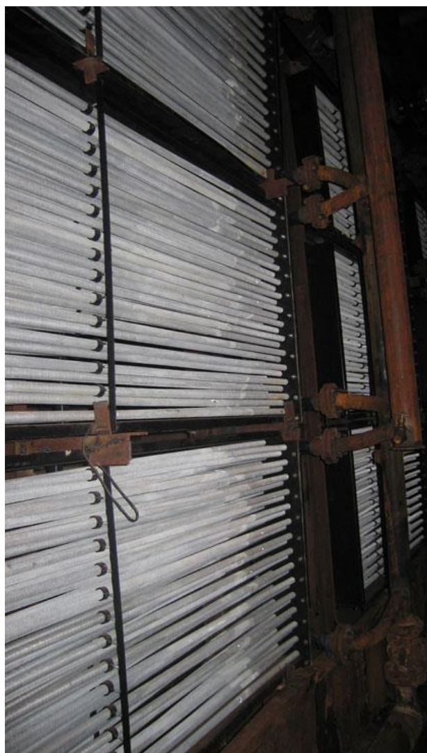
Рисунок 10.9. Расположение алюминиевого калорифера КТР-А в выработке
