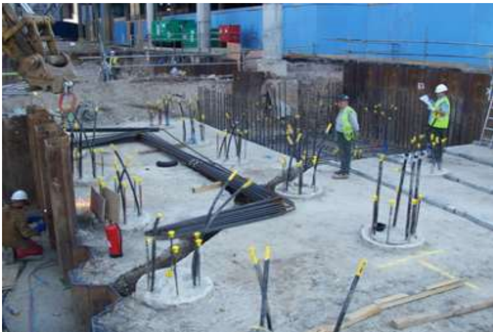
Рис. 1.8. Організація сполучення колекторів теплових насосів з енергетичними палями.
