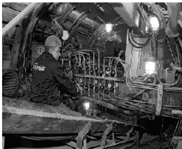
Рисунок 5 – Будівництво каналізаційного колектору за допомогою прохідницького щита
