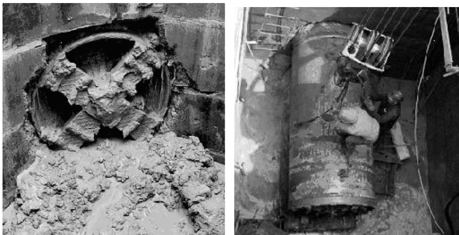
Рисунок 3 – Будівництво каналізаційного колектора по вул. Стеценка м. Києва
