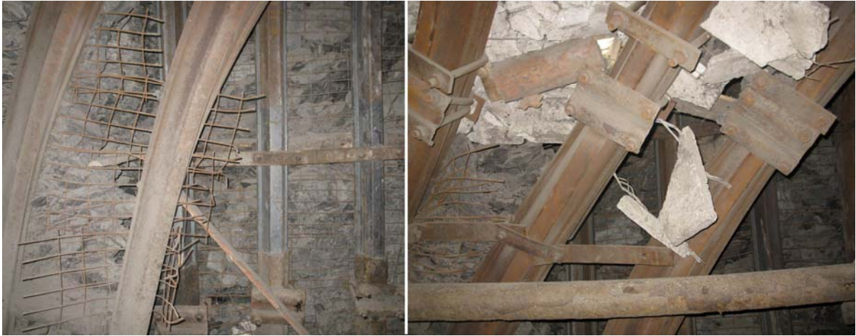
Рисунок 5.9 – Наклон рам крепи на участке перекрепления
