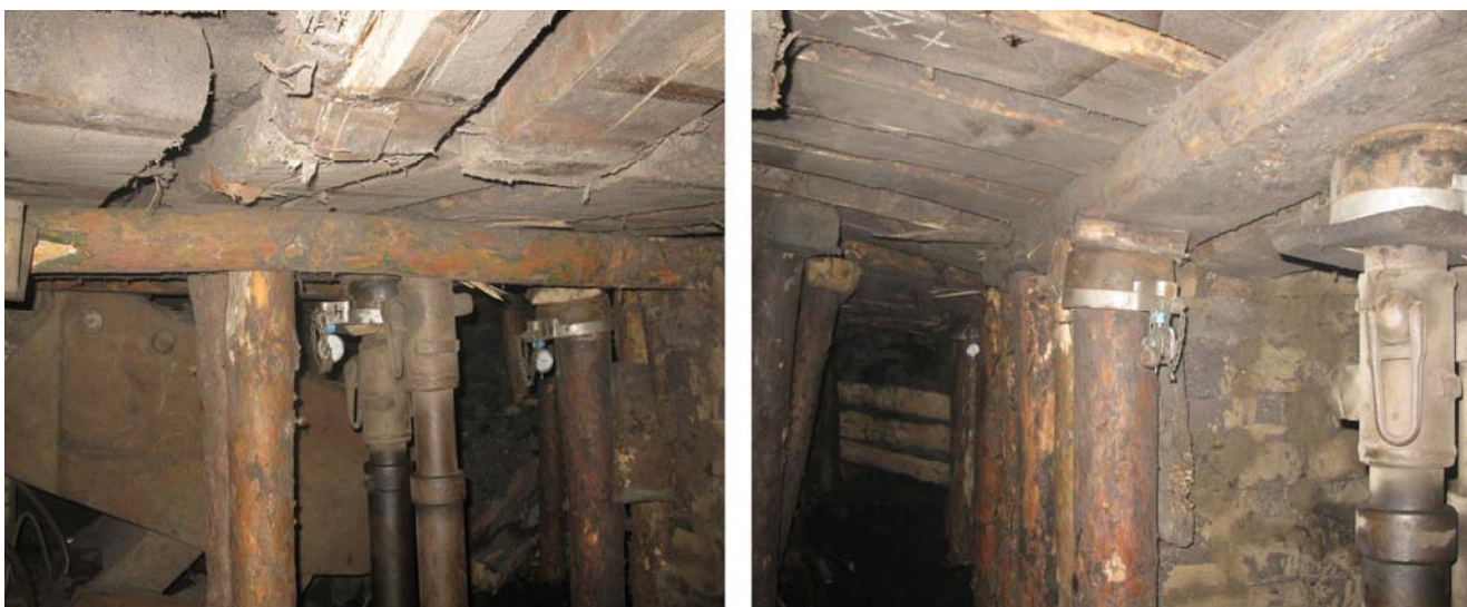
Рисунок 2.13 – Замерные станции, оборудованные динамометрами
