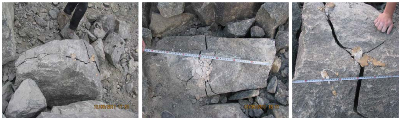
Рисунок 6.2 – Общий вид разрушенных негабаритных блоков гранита
