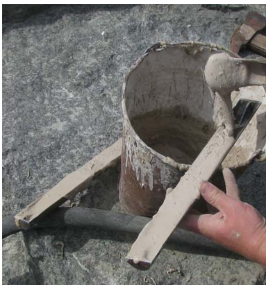
Рисунок 6.7 – Заливка НРС в патроны
