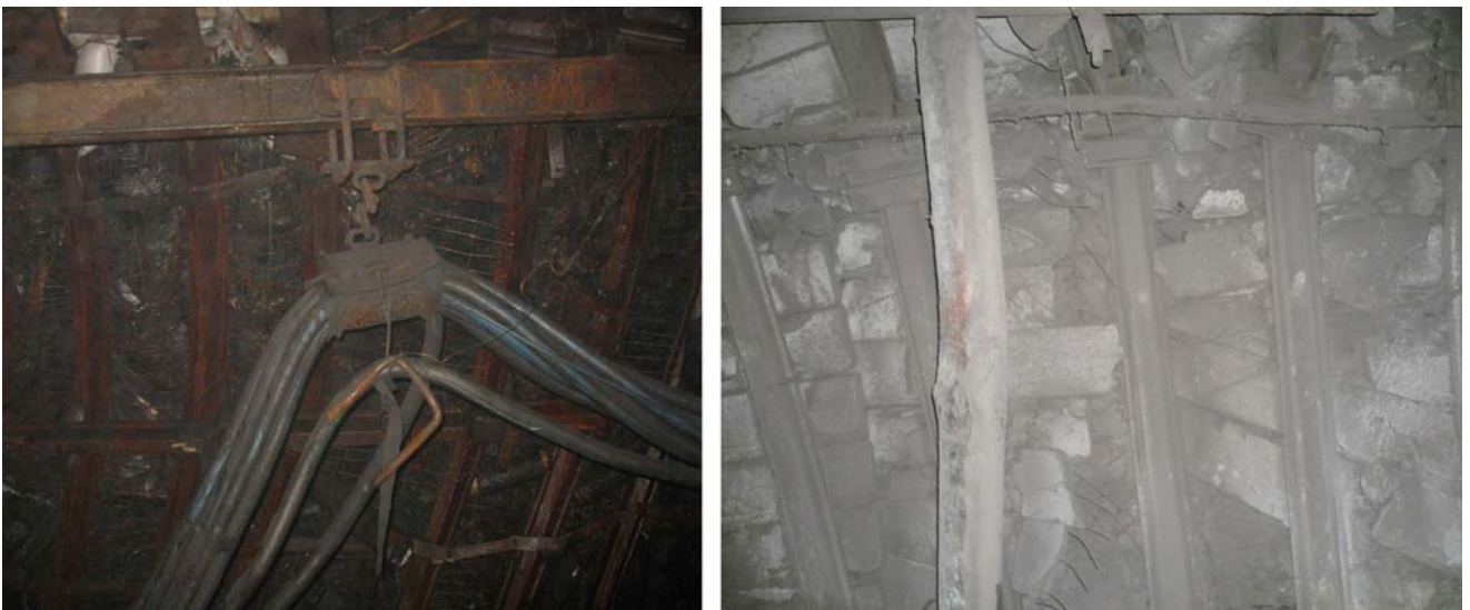
Рисунок 5.19 – Наклон рам крепи в штреке (а) и квершлагае (б)
