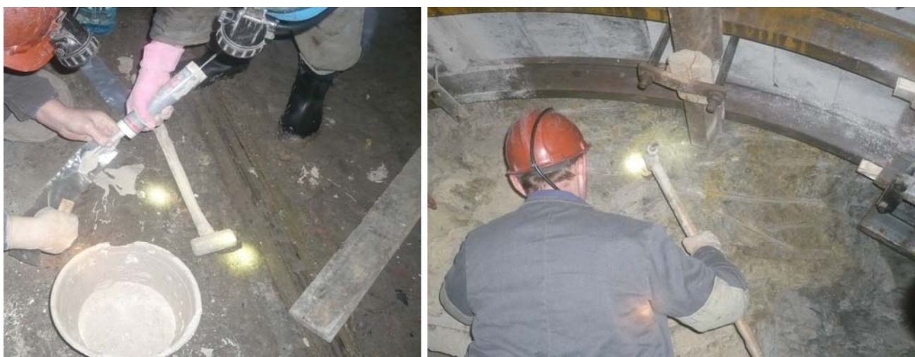
Рисунок 6.11 – Заливка НРС в ампулы (а) и герметизация шпуров с НРС (б)
