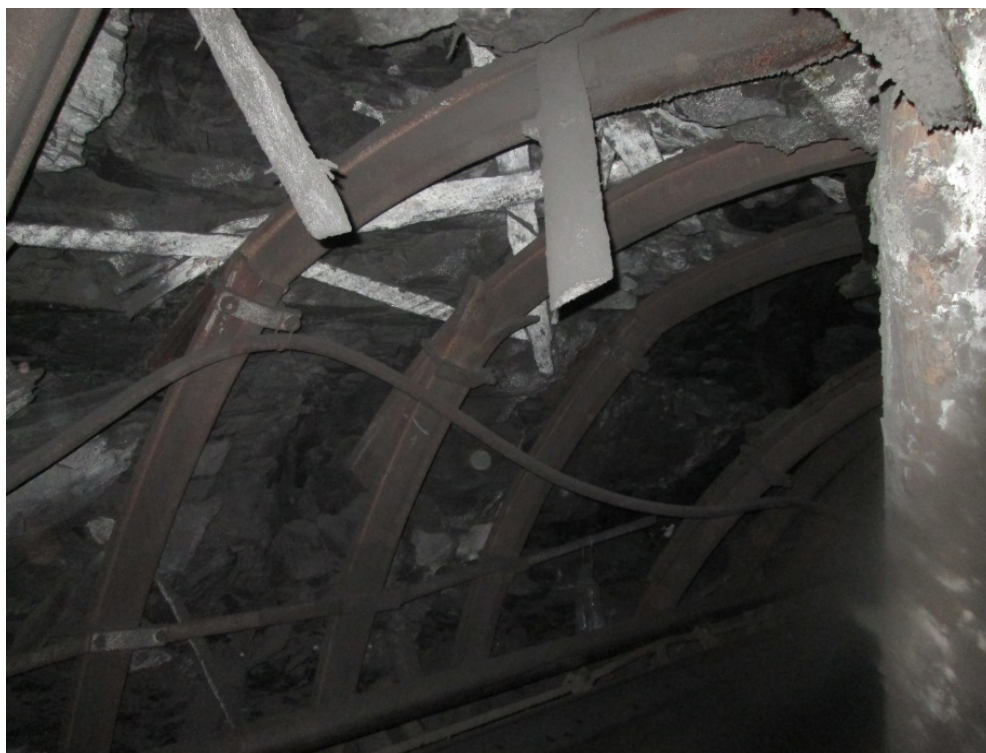
Рис. 2.45 Разрушение ножки крепи
