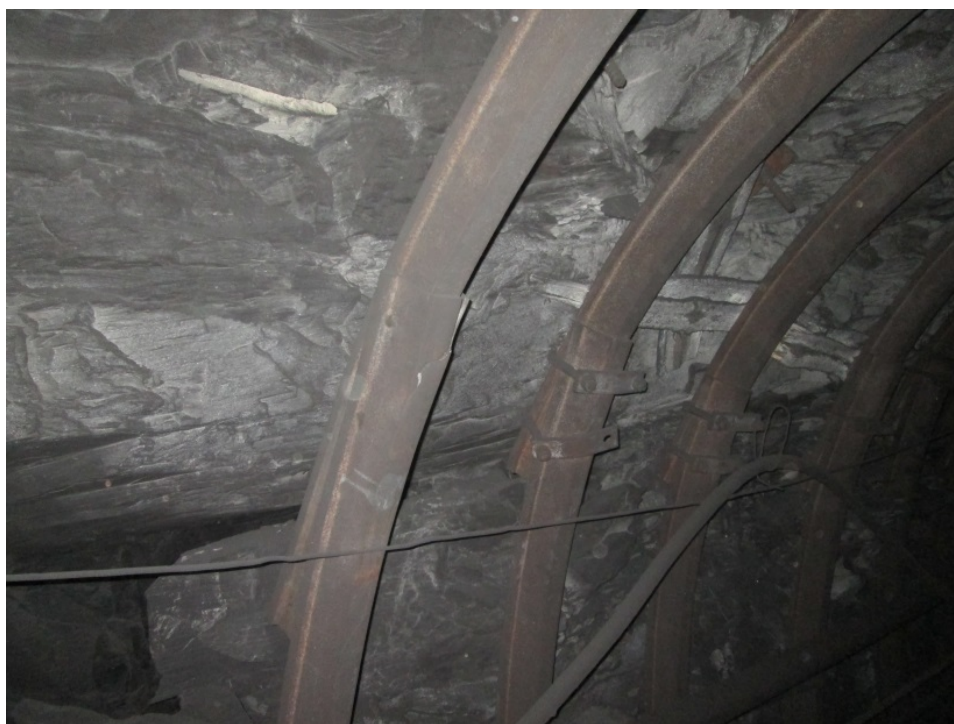
Рис. 2.46. Место разрыва хомута
