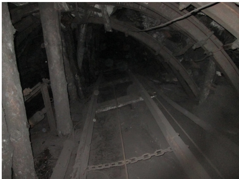
Рис. 2.44 Пучение пород почвы (ПК13+5)
