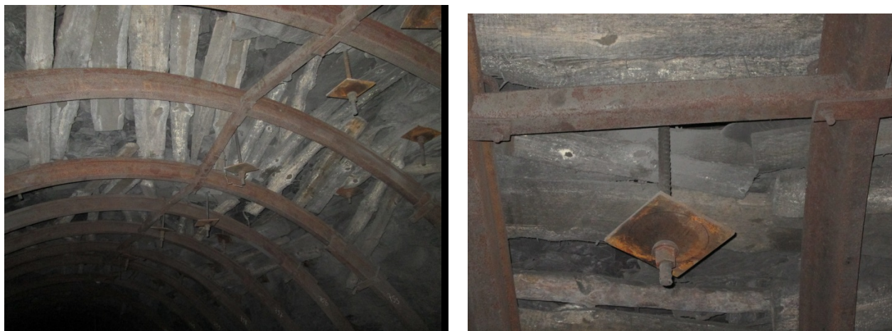
Рис. 2.56. Неправильно установленная анкерная крепь
