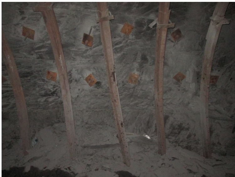
Рис. 2.55. Наклон рам крепи в сторону забоя
