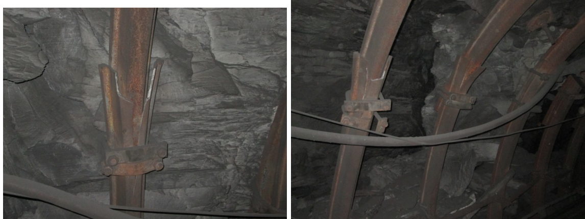
Рис. 2.51. Разрушение ножек крепи
