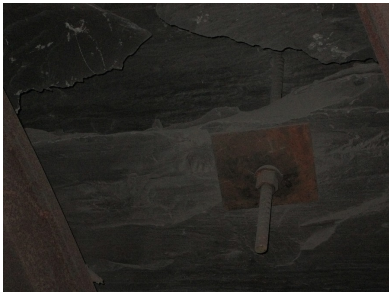
Рис. 2.57. Отслоение боковых пород
