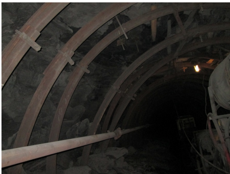
Рис. 2.58 Отсутствие контакта рам крепи с боковыми породами
