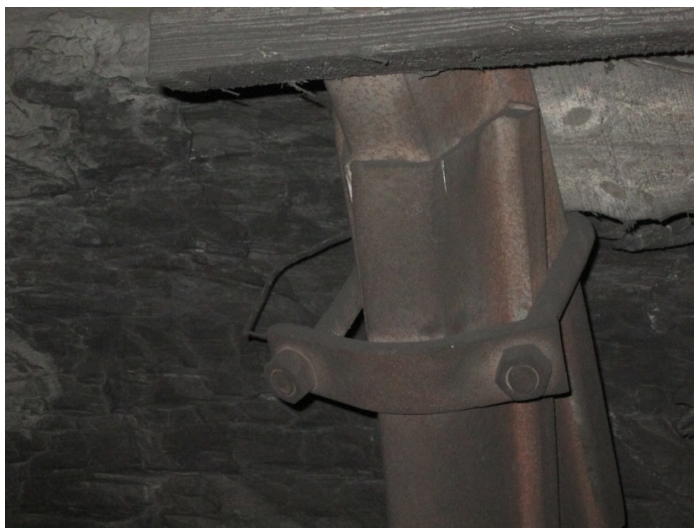
Рис. 2.52. Разрывы ножек крепи
