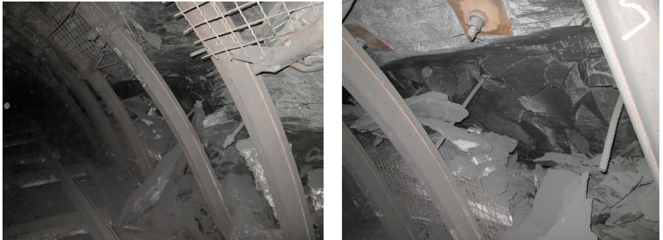
Рис. 2.43. Отслоение пород бровки (ПК13)
