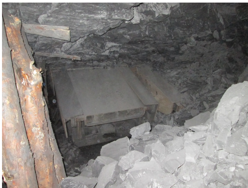
Рис. 2.54. Обрушение пород непосредственной кровли
