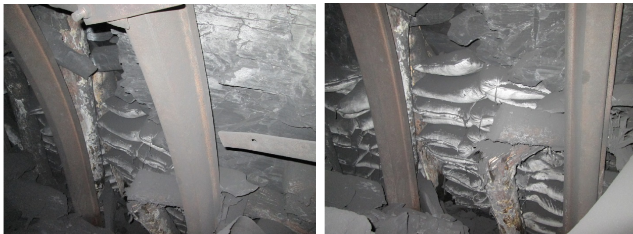
Рис. 2.49. Наклон полосы из «Текхарда» в сторону выработки
