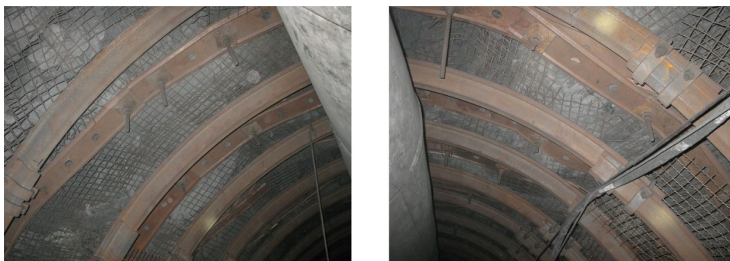
Рис. 2.60. Состояние кровли в местах применения анкерной крепи
