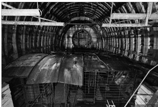
Рис. 2. Зона примыкания будущего эскалаторного тоннеля
