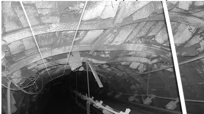
Рис. 2. Пример негативного проявления горного давления в протяженных выработках южного крыла шахты «Россия»
