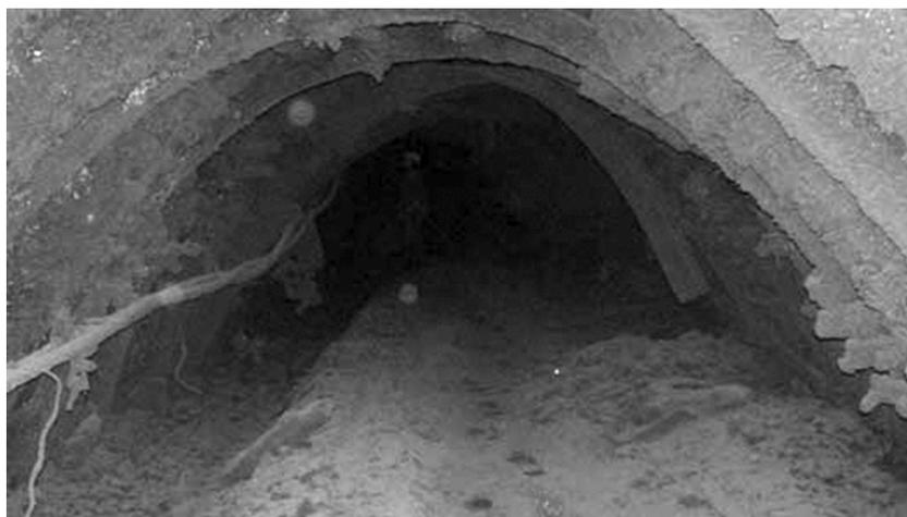
Рис. 3. Пример негативного проявления горного давления в почве выработок
