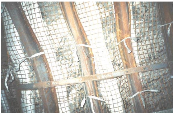
Рис. 3. Поздовжнє скручування рамного спецпрофілю
