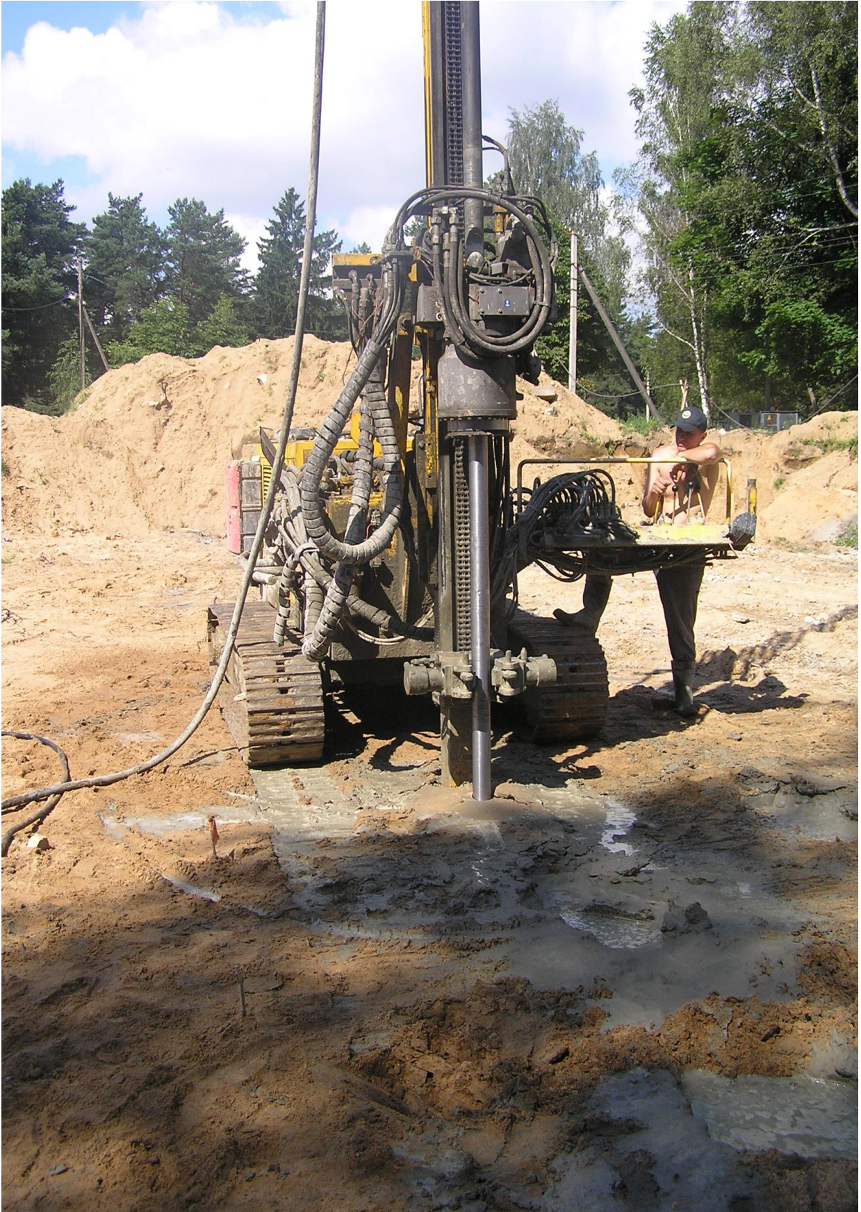
Рис. 3.3.9. Промивання забою цементним розчином
