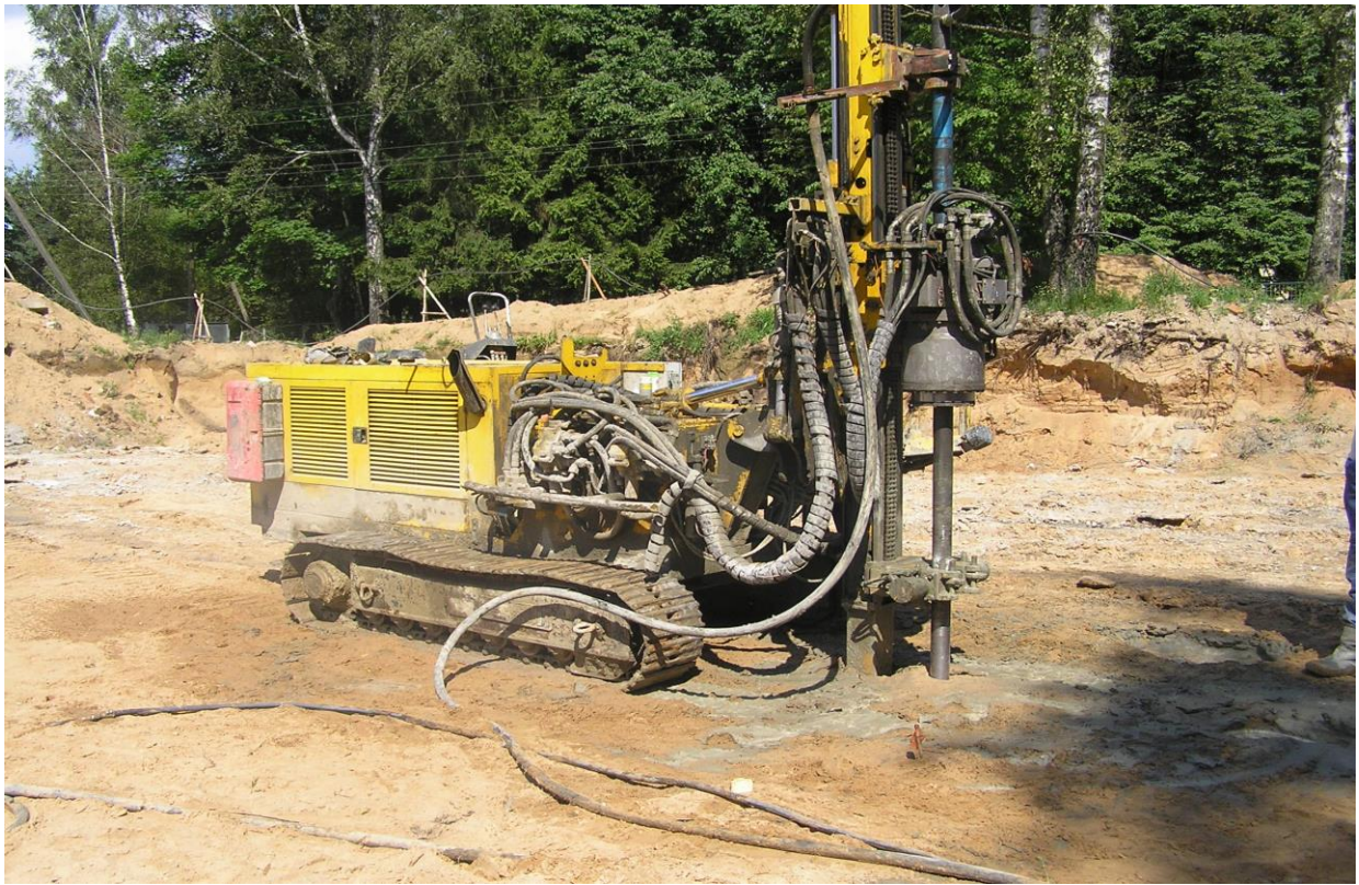
Рис. 3.3.10. Покроковий підйом монітора з одночасною подачею розчину через форсунки.
