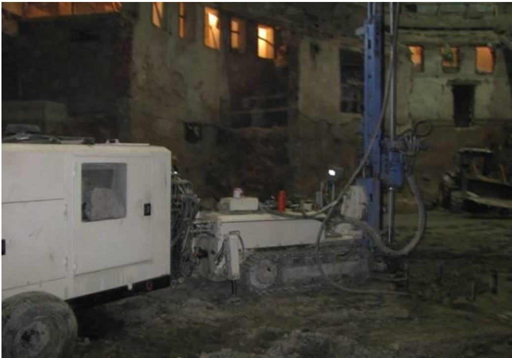
Рис. 1.3.5. Малогабаритна установка, яку використовували для підсилення основи з використанням методу струменевої цементациї.
