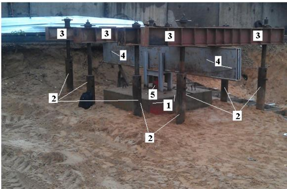
Рис. 3.3.12. Експериментальна установка, призначена для випробувань фундаменту на посиленій з використанням струменевої цементациї основи.
