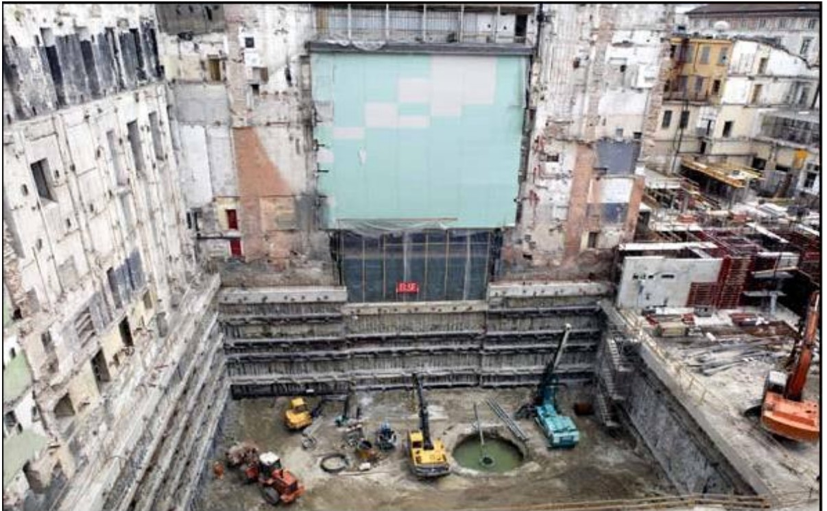
Рис. 1.3.2. Кріплення бортів котловану (загальний вигляд)
