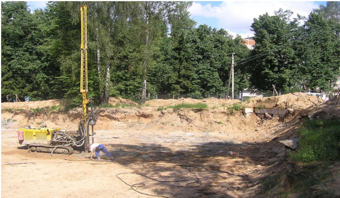
Рис. 3.3.8. Розбурювання лідерної свердловини.
