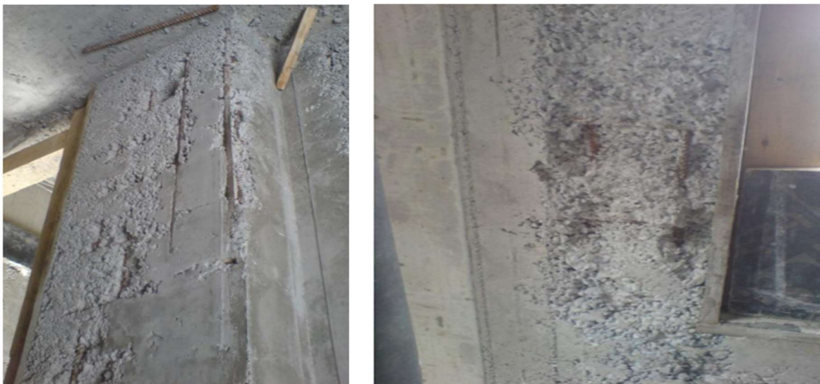
Рисунок 1– Примеры выявленных дефектов в колоннах 5-го этажа
