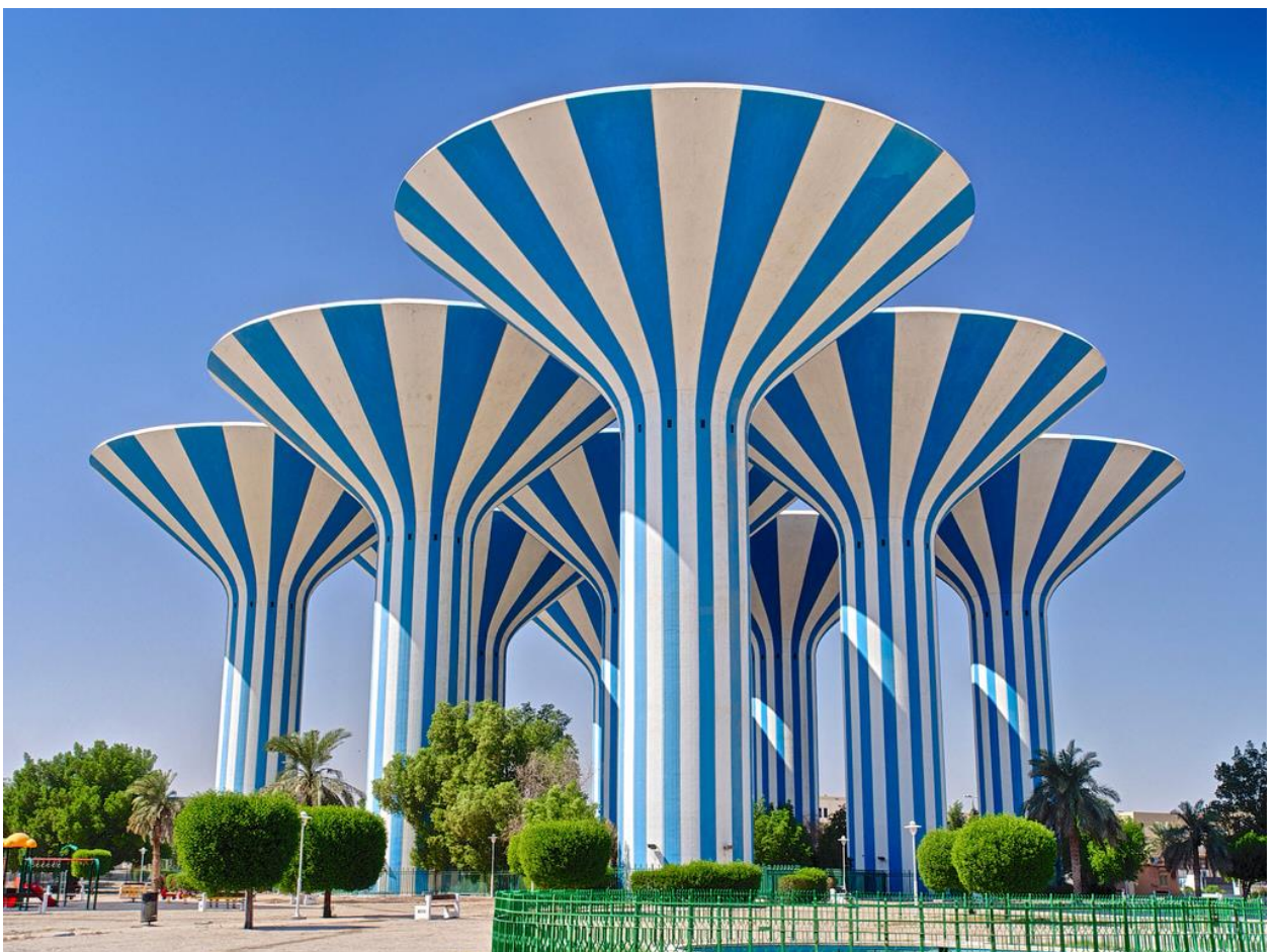
Рис. 1.5 – Приклад водонапірних веж
