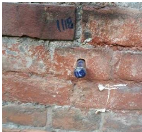
Мал. 6.5 – Деформаційний репер у цегляній стіні
