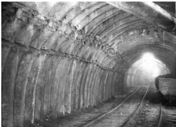
Виробка з кріпленням АНТ
