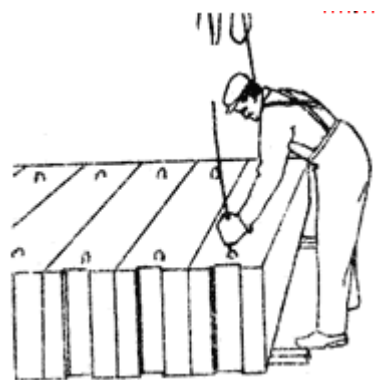
Рисунок 3.4 – Строровка блоку.
