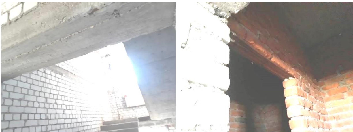
Рисунок 3.7 – Фактичні конструктивні рішення перемичок в будівлі
