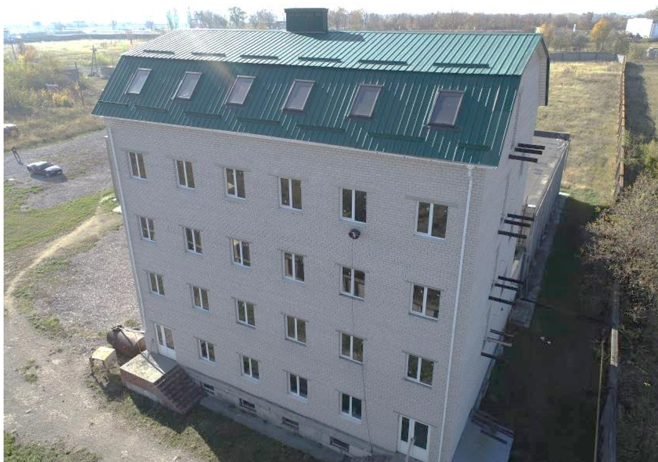
Рисунок 2.3 – Будівля адміністративно-побутового корпусу (фасад з входною групою)
