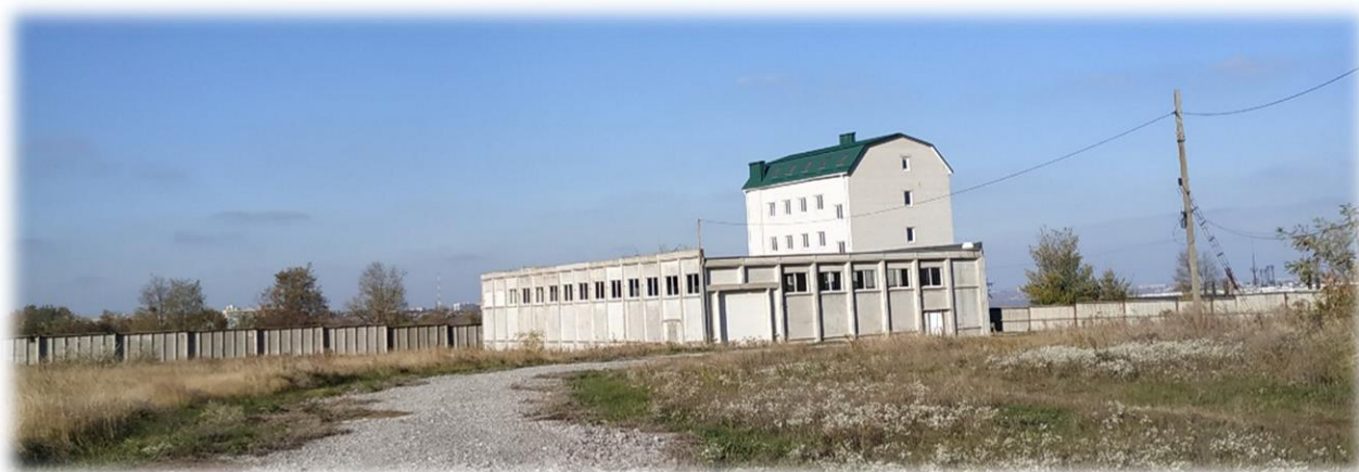
Рисунок 2.2 – Будівля адміністративно-побутового корпусу (загальний вид ділянки)
