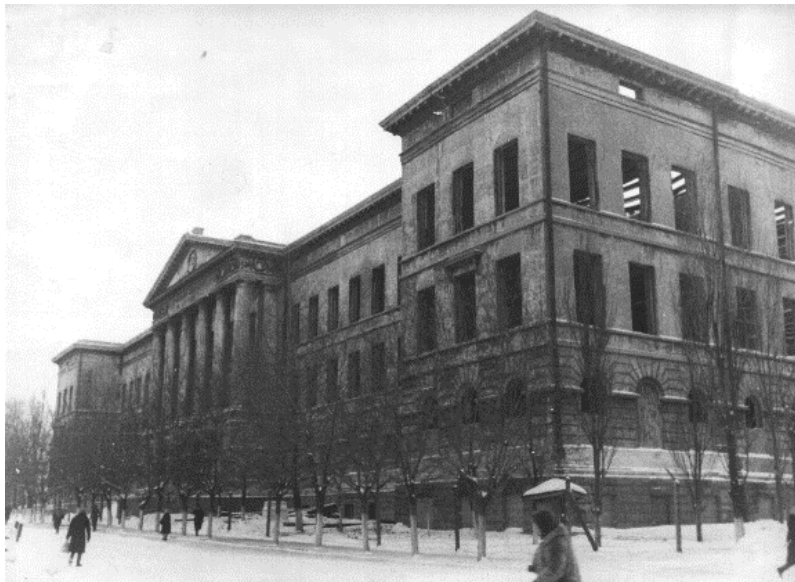
Восстанавливается главный корпус ДГИ. 1948 год
