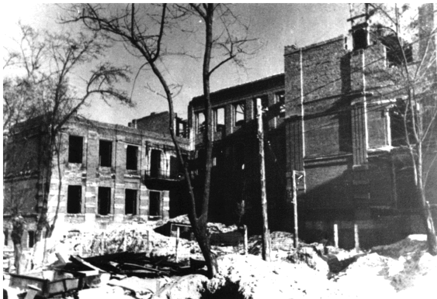
Разрушенный в годы войны 2-й корпус Горного института, 1944 г.
