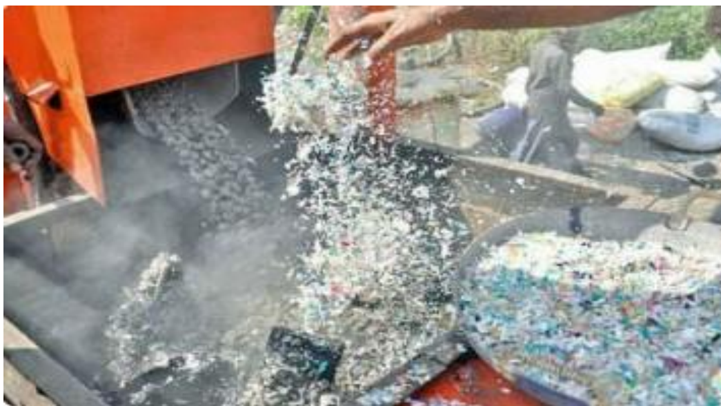
Рисунок 3.8 – Додавання подрібненого пластику до асфальту під час будівництва
