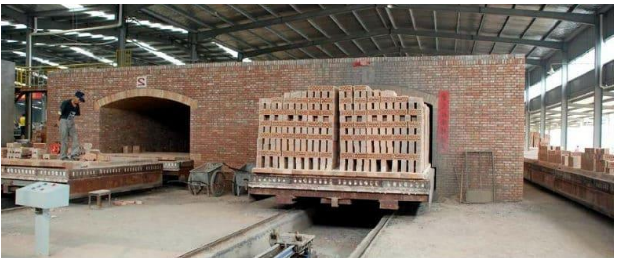
Рисунок 1.5 – Зовнішній вигляд тунельної печі для випалювання керамічної цегли
