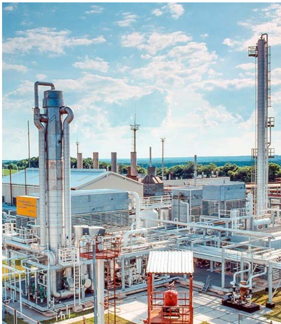
Рисунок 1.6 - Випарна колона INT-OCIRZ040
