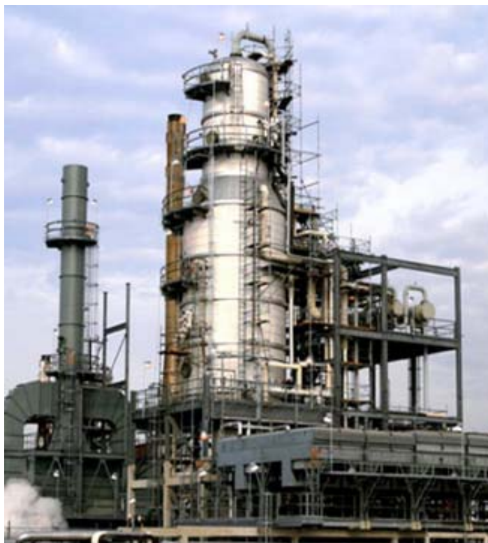
Рисунок 1.6 – Вакуумна дистиляційна колона VDU-80-0,005/0,30
