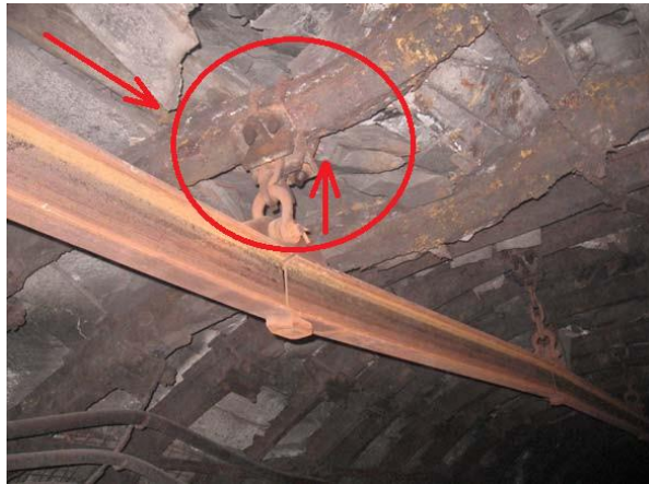
Рисунок 2.11 – Наслідки негативної дії динамічних навантажень рухомого складу ПДМ на аркове кріплення і покрівлю виробки
