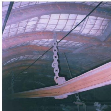
Рисунок 3.1 – Стан несучих арок при традиційному кріпленні монорейкового постапу
