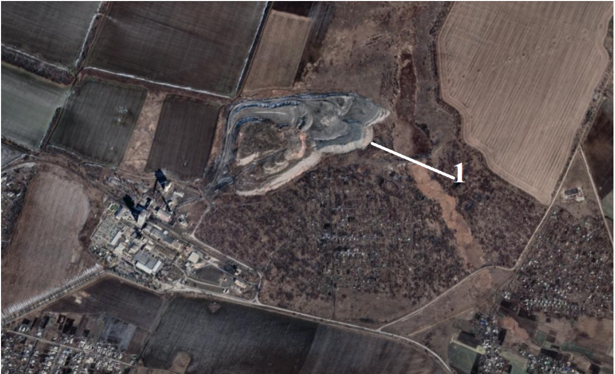
Рисунок 4.8 – шахта «Західно-Донбаська»: 1 – відвал відходів вуглевидобування ( http://surl.li/tvkil )
