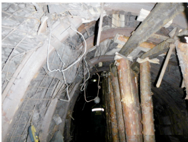
Рисунок 1.9 – Фрагменти стану кріплення виїмкових виробок шахт Західного Донбасу в зоні впливу очисних робіт: a – фрагмент №7; б – фрагмент №8; в – фрагмент №9
