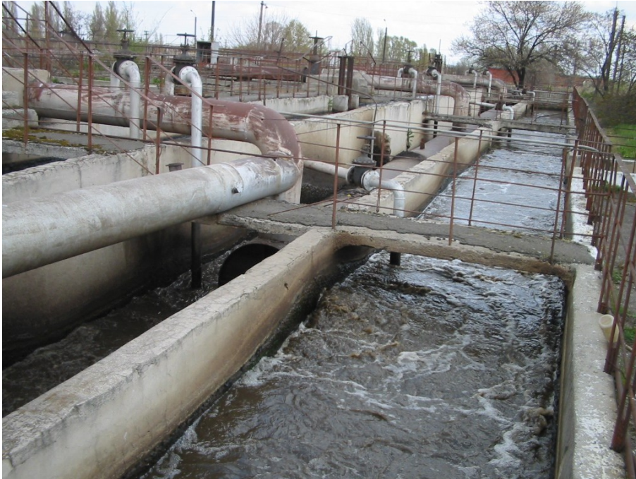
Рисунок 1.5 – Аеротенк – змішувач на Лівобережній станції аерації
