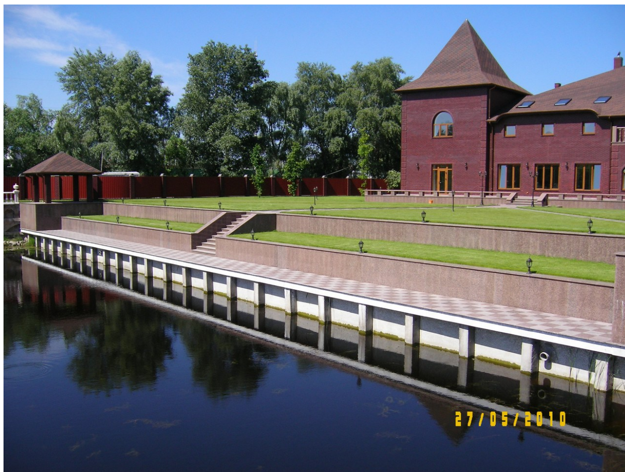
Рисунок 1.3 – Укріплення берега палями і плитами
