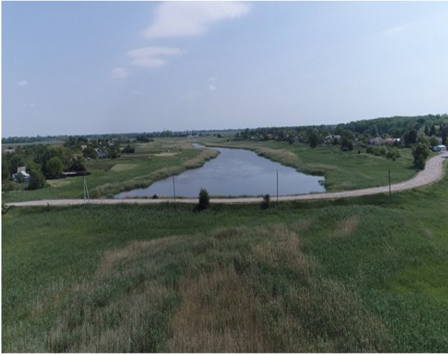
Рисунок 2.6 - Глуха дамба без пропускної споруди на р. Чаплинка до розчистки її русла (а) та після (за даними на червень 2019 р.) (б) на ділянці від с.Оленівка до м. Магдалинівка Магдалинівського району
