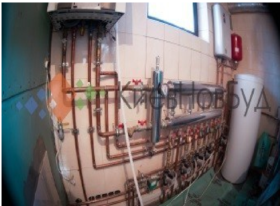
Рисунок 2.1 - Типове розташування теплового насосу, баку термоса
