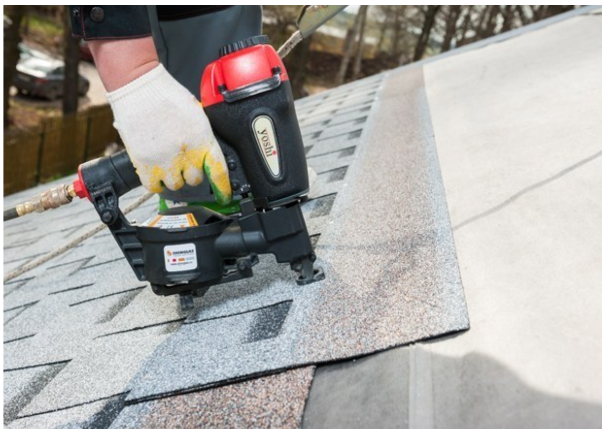
Рисунок 3.5 - Встановлення гнучкої покрівлі
