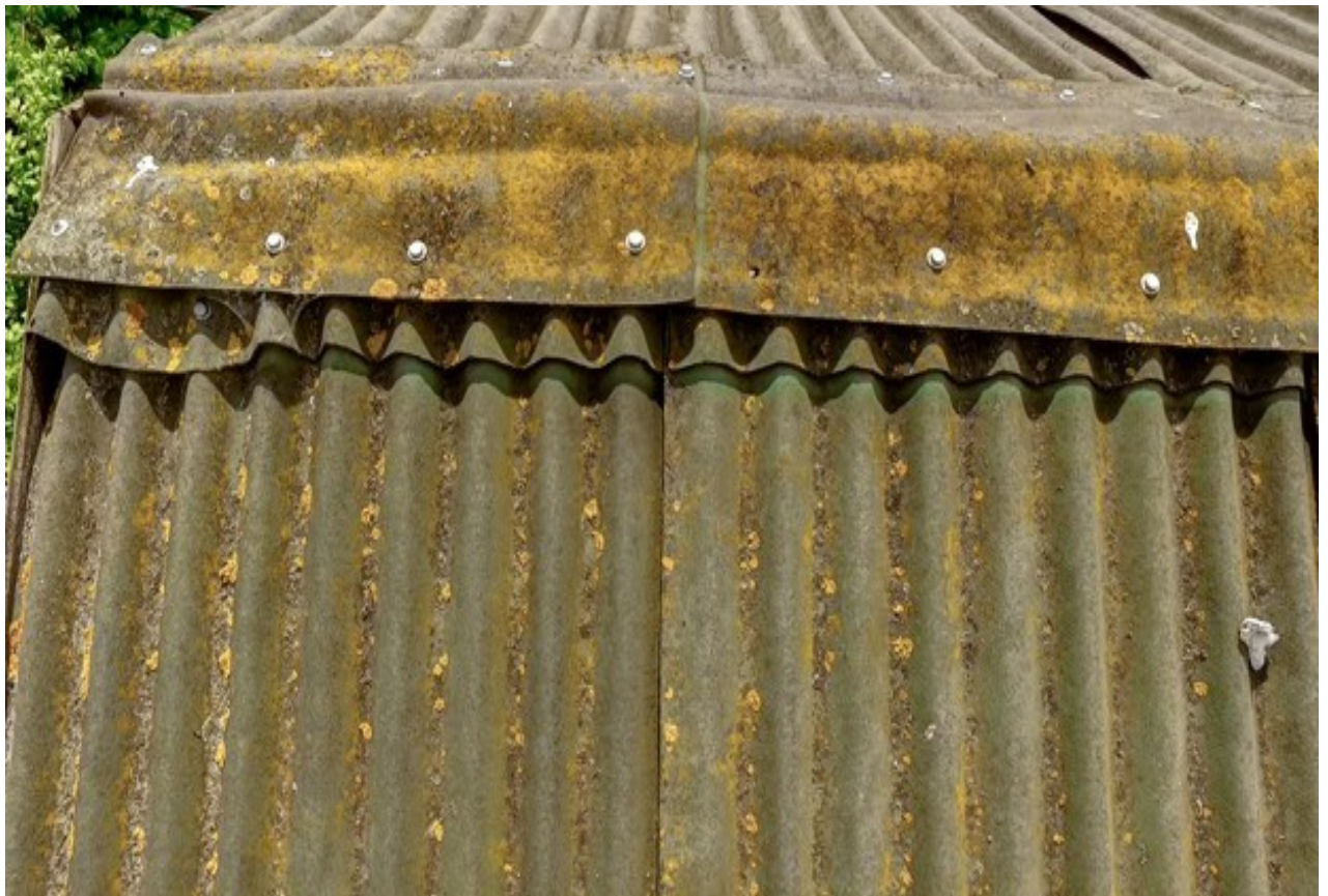
Рисунок 3.4 - Приклад азбестової покрівлі
